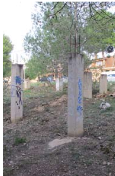
Pilares en el barranco La Font L.V.
