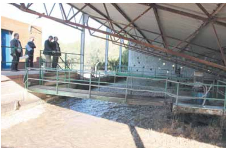
Visita del alcalde y los técnicos a comprobar las obras
