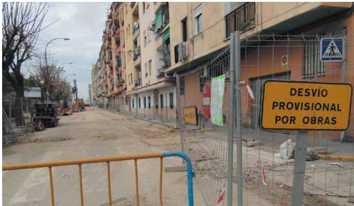
La calle Santísimo Cristo de la Fe cortada al tráfico por las obras
